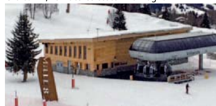
Garage à cabine, TC Villards – Arc 1800.
