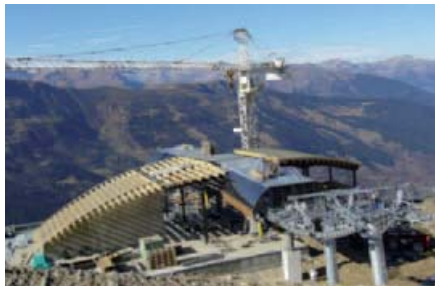
Construction de la couverture de l'ascenseur à cabine et des locaux de commande, TC Saulire Express – Meribel Alpina.
